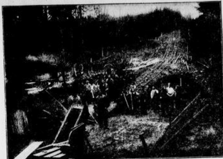
Die Sprungschanze im Bau
