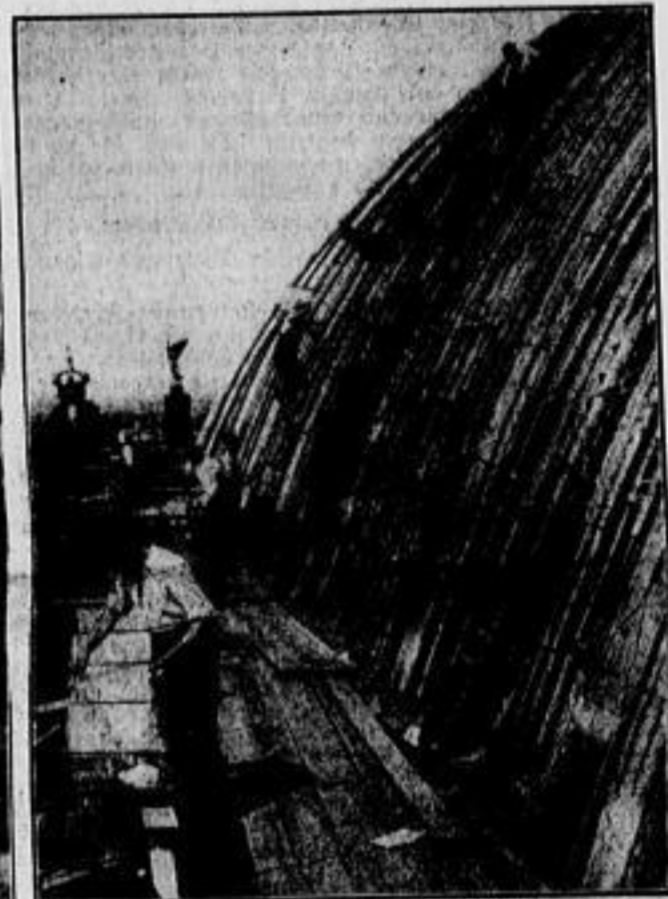
Die Wiederherstellungsarbeiten an der Kuppel des Reichstagsgebäudes
