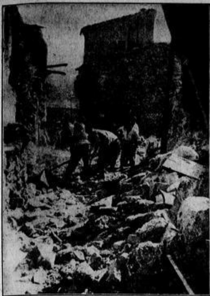
Die Lage im italienischen Erdbebengebiet in den Abruzzen hat sich durch ein heftiges Nachbeben noch verschlechtert. Nach einer bisher vorliegenden Zählung sind in 24 von den Erdbeben betroffenen Abruzzendörfern etwa 400 Häuser ganz eingestürzt, 900 schwer beschädigt und 3000 haben Risse erhalten. Das umfassende von Mussolini angeordnete Hilfswerk hat wenigstens für sofortige Notunterkunft der betroffenen Bevölkerung gesorgt. Unser Bild zeigt eine Militär-Abteilung bei den Aufräumarbeiten in Lama Taranta.
