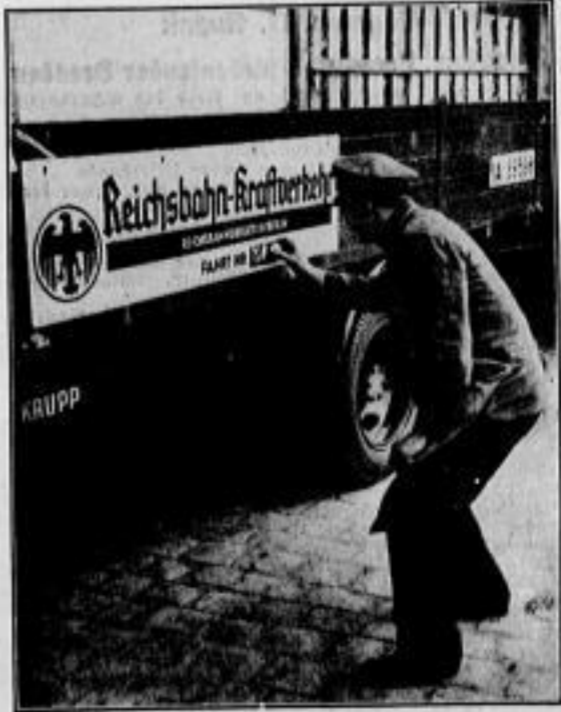
Ein Wagen des Reichsbahn-Kraftverkehrs erhält seinen Zugnummer
