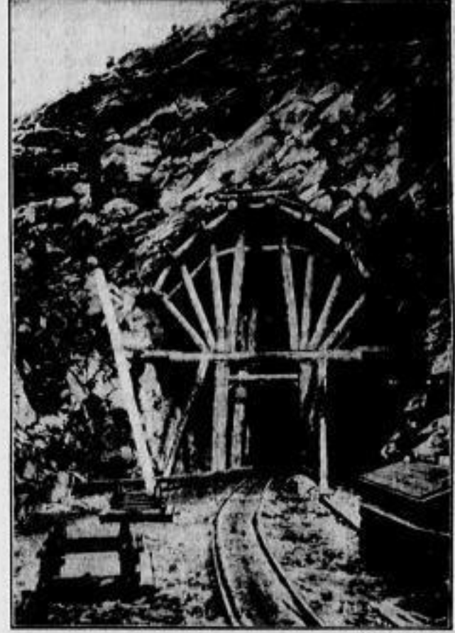
Der südliche Ausgang des Gleisbergstunnels mit dem Aussteigerüst
