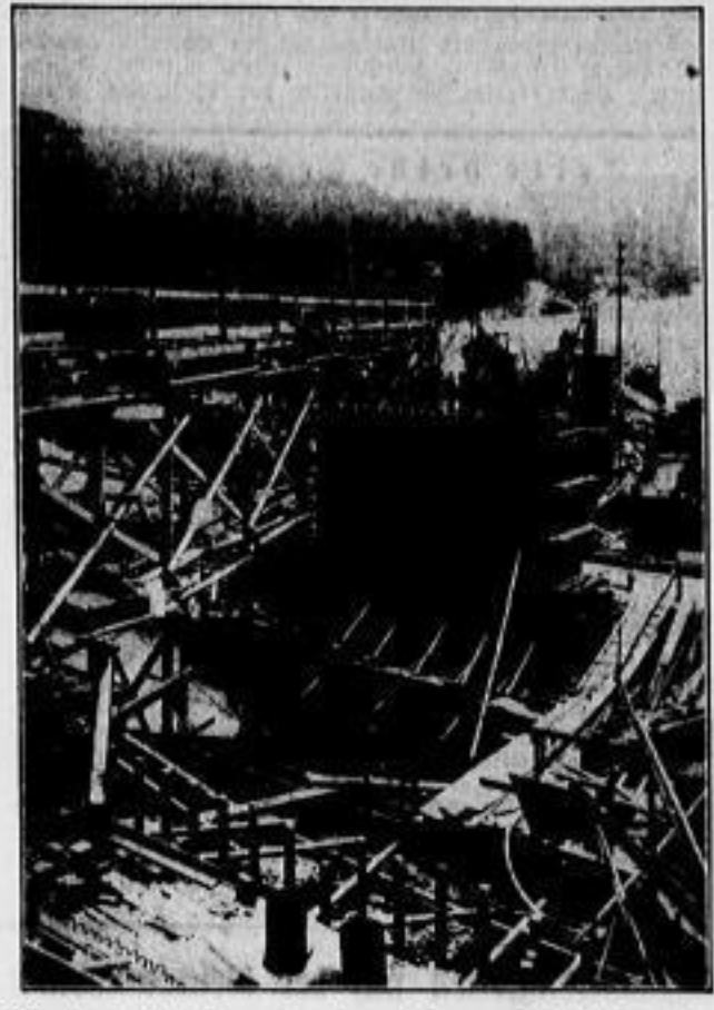
Bau der Talbrücke an der oberen Hüttenmühle bei Glashütte
