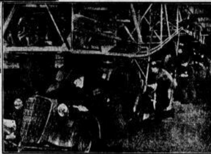
Am hängenden Laufband findet in Rüsselsheim der Wagen seine letzte und endgültige Gestalt
