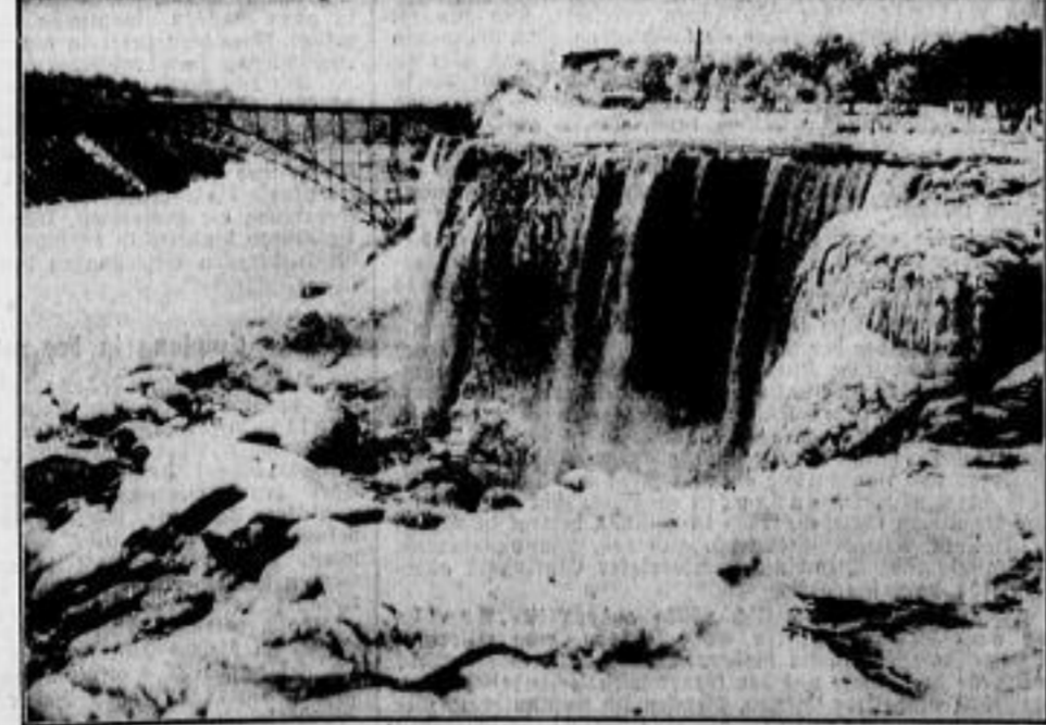
Die eingestürzte „Honeymoon-Bridge“
