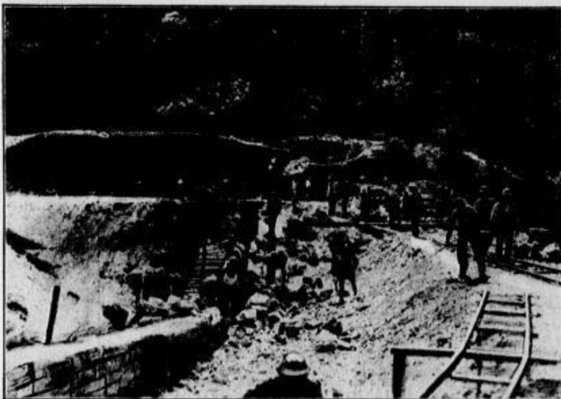
Italiens Aufbauarbeit in Abyssinien: Straßenbau auf der Strecke Komara—Addis Abeba
