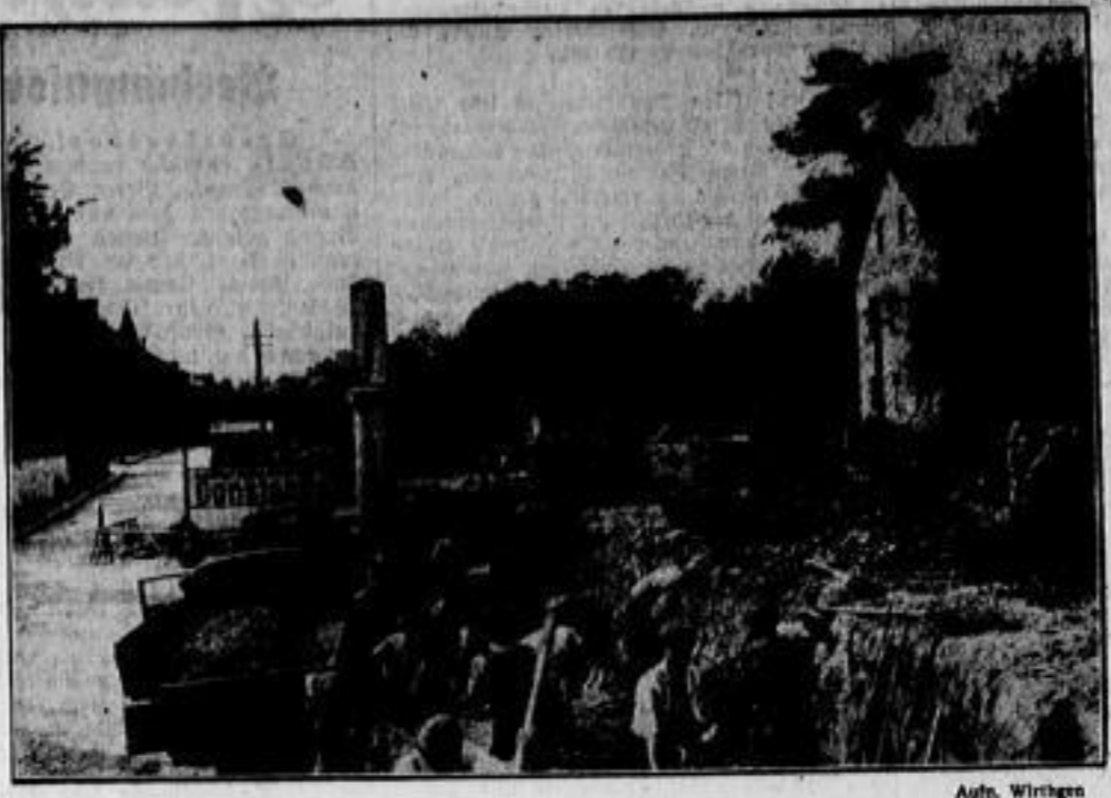
In einer Länge von 250 Metern ist die Autobahn-Subringerstraße auf Altstädter Seite schon im Bau und führt dem Hirschinghauspark zu
