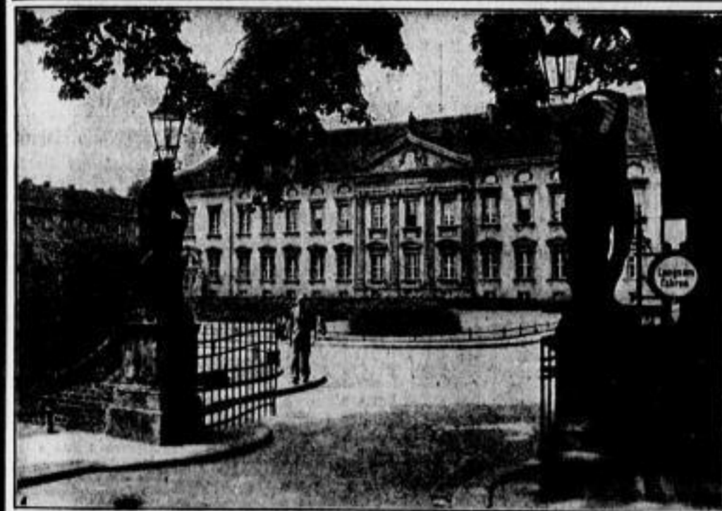
Das Schloss Bellevue im Berliner Tiergarten wird auf Anordnung des Führers zu einem Gästehaus des Reiches für Staatsbesuche und Kongresse umgebaut
