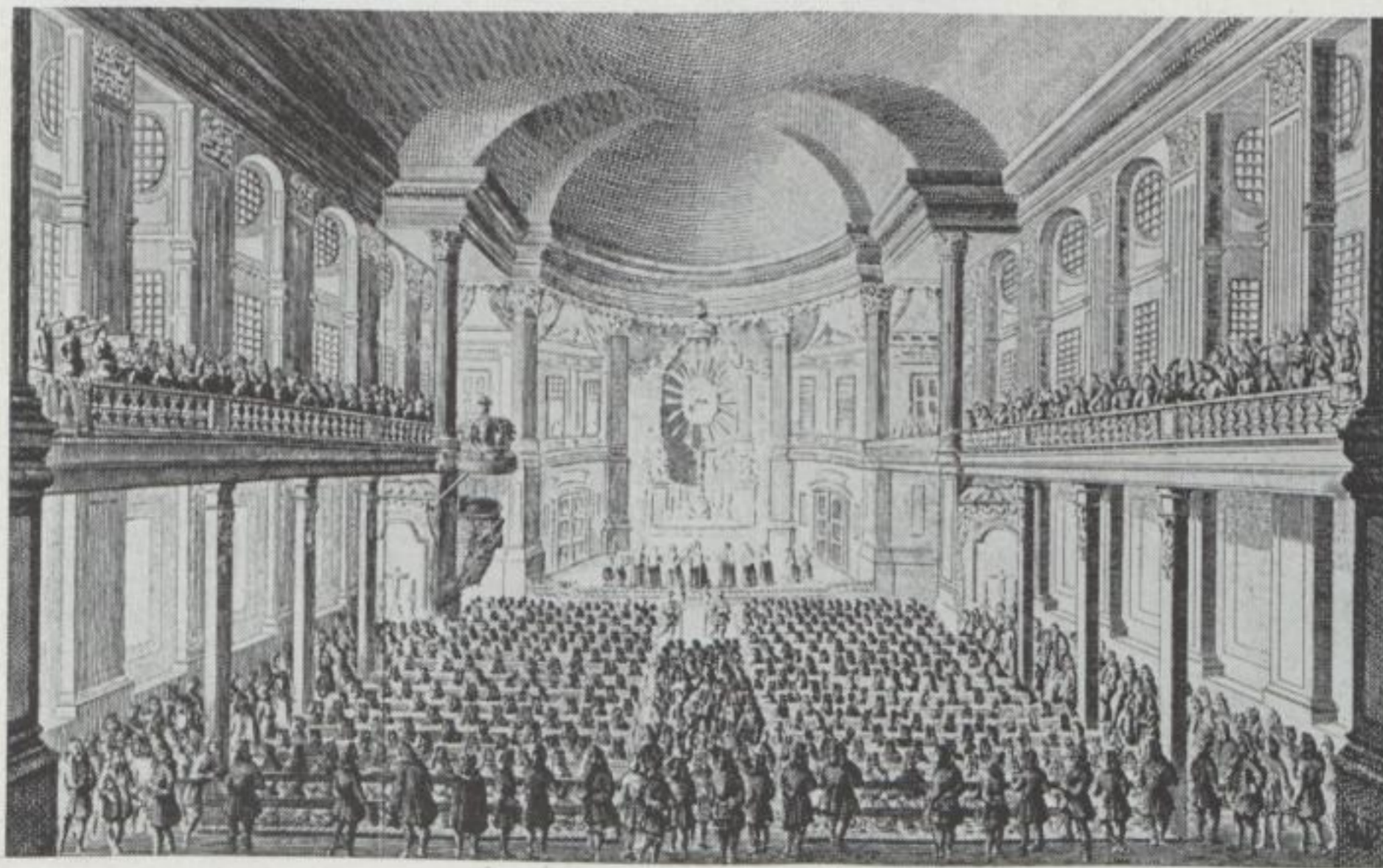
Comödienhaus nach dem Umbau zur kathol. Kapelle
