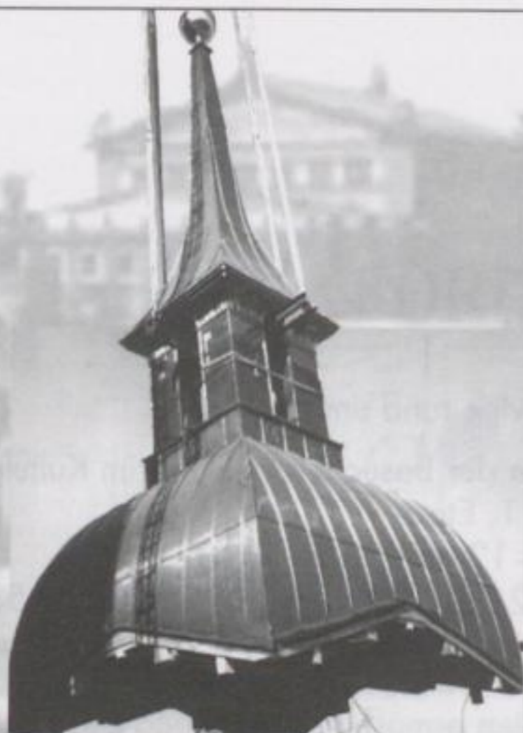
Aufsetzen des wiedererstellten Turmhelmes der Annenkirche am 24. April 1997
