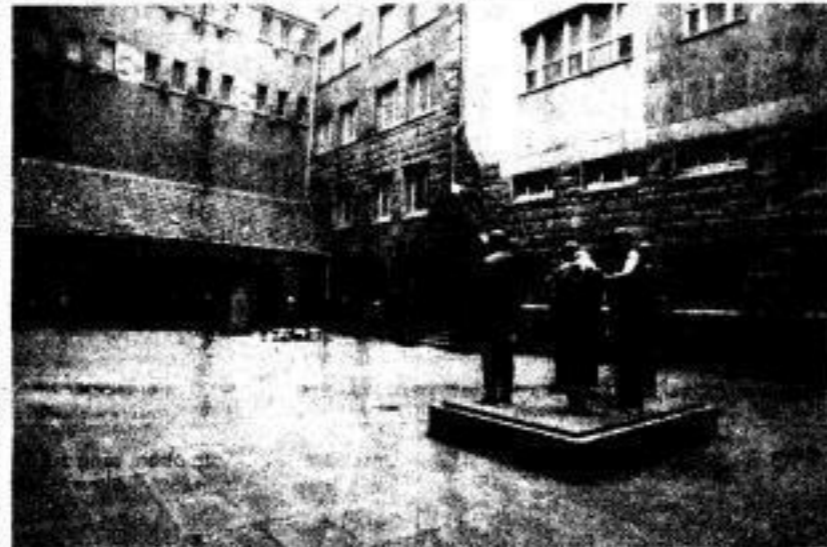
Was geschah nach 1945 hinter diesen Mauern? Foto: Sütterlin
