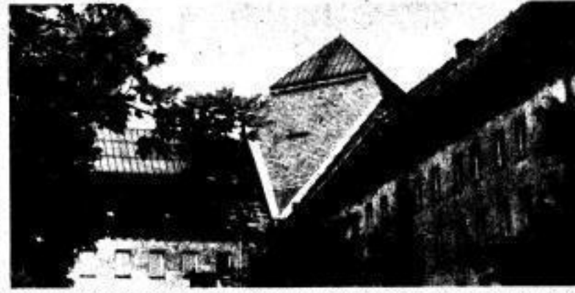
Dieser Teil des Daches vom Georg-Schumann-Bau wurde in diesem Jahr vom Bauhof in Ordnung gebracht.
