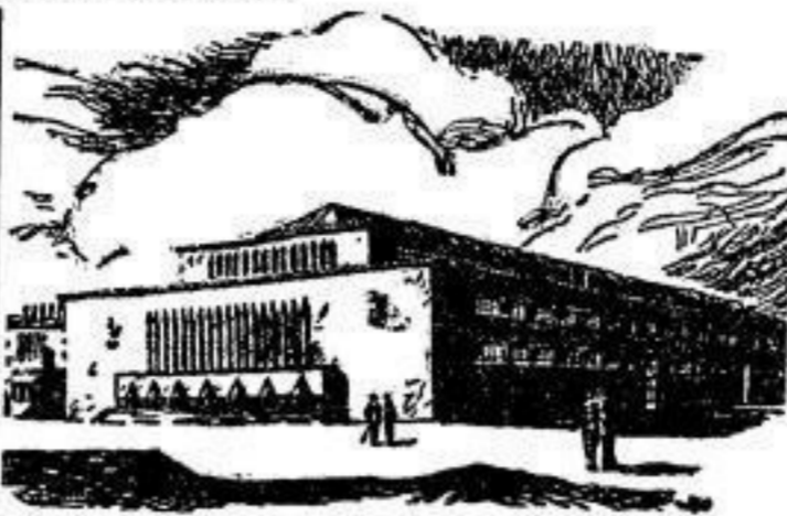
anlagen, hergestellt und aufgestellt durch die Gebrüder Bauhaus, A. O., Berlin-Tempelhof.
