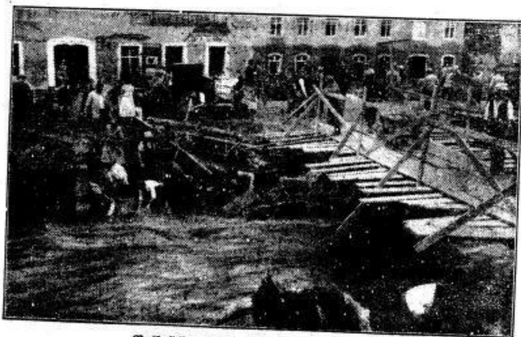
Notbrücke am Markt in Berggiehübel
