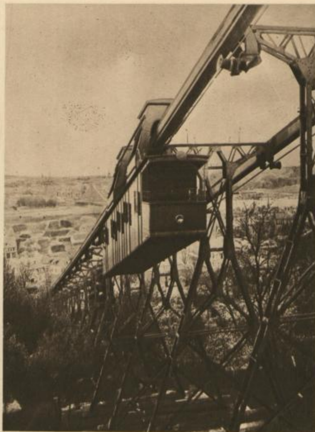
Elbaufwärts: Loschwitz. Erste Bergschwebebahn der Welt.
