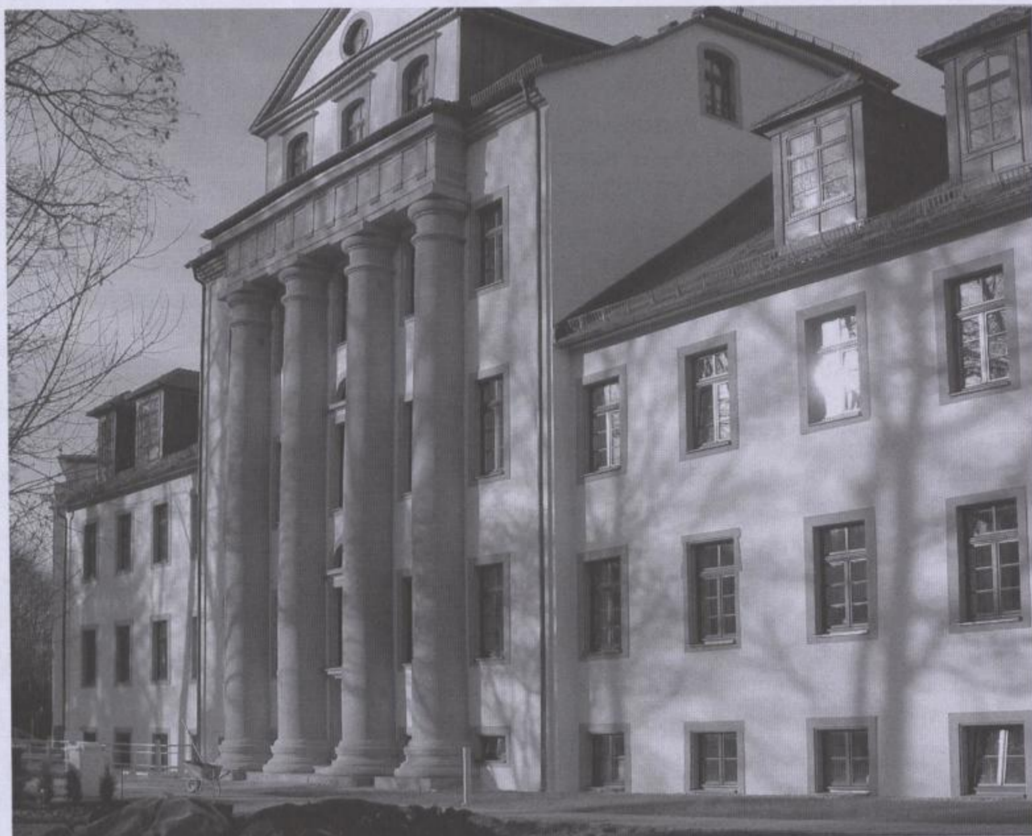
Ehemaliges Wohn- und Kontorhaus der Bernhardschen Spinnerei von 1800 in Chemnitz-Harthau, heute Altersheim
