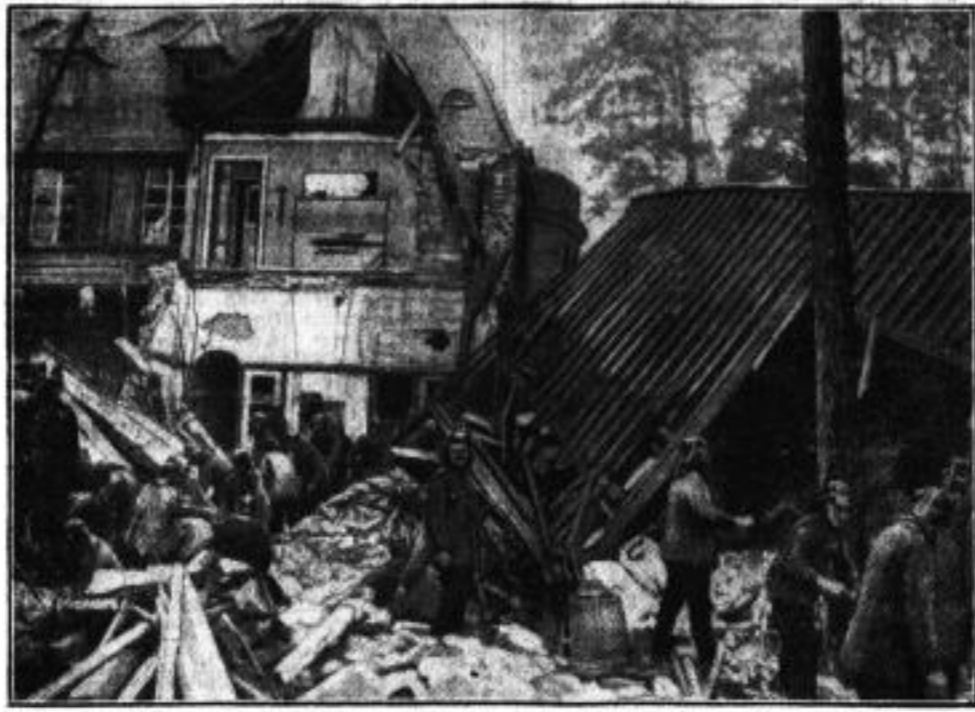
Die schwerbeschädigte Villa mit dem Dach des Laboratoriums (rechts)
