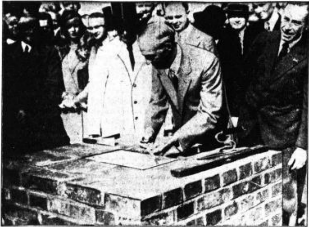
Henry Ford traf dieser Tage in Köln ein und legte den Grundstein zu seinem neuen Automobilwerk, das mit 600 neuen Maschinen eine der größten und modernsten Industrieanlagen Kölns werden wird.
