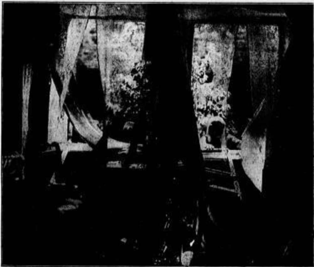
Einberstete Fensterscheibe in einer Wohnung in Braunsdorf bei Reinsdorf
