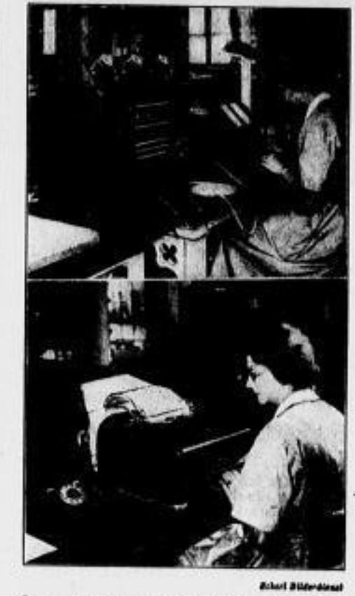
Oben die Ausfunktstelle für den Fern-sprechverkehr, unten eine Teilnehmer-Apparatur mit der Nummernscheibe (links).
