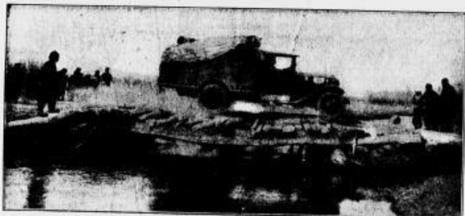
Brücke südlich von Korla. Nach Sven Hedin „Die Stadt des Großen Pferdes“, Mit Genehmigung des Verlags H. W. Brockhaus, Leipzig
