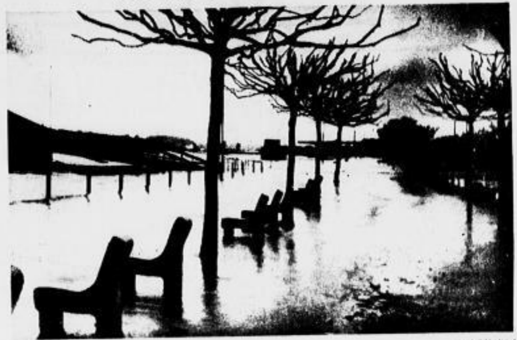
Die zahlreichen Regengüsse der letzten Zeit haben, wie bereits berichtet, das Wasser des Rheins und seiner Nebenflüsse stark ansteigen lassen. Bei Andernach ist die Uferpromenade völlig überflutet.
