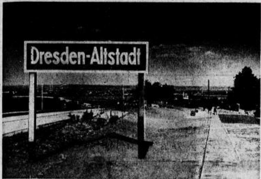
Die gestern fertiggestellte Ab- und Auffahrtsrampe zur Reichsautobahn am Kirchberg in Dresden-Briesnitz. Ganz rechts die Abfahrt, in der Mitte die neue Zufahrt und links das Band der Autobahn, das hinüber nach der Neustadt führt.
