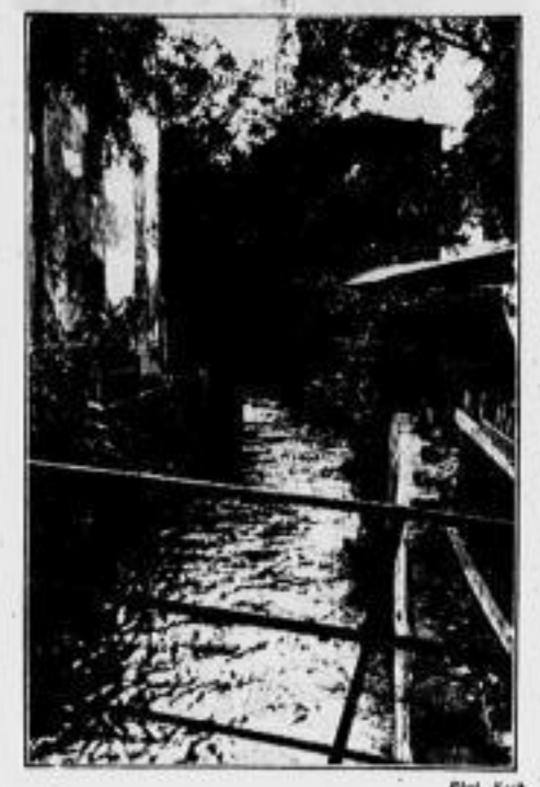
Am 9. Oktober 12 Uhr wird den alten Mühlgraben in Dresden zum letztenmal das schnelle Wasser durchströmen, da es dann der Weißeritz zugeleitet wird. Unser Bild zeigt einen Ausschnitt des Mühlgrabenlaufs zwischen Packhof- und Deventerstraße.
