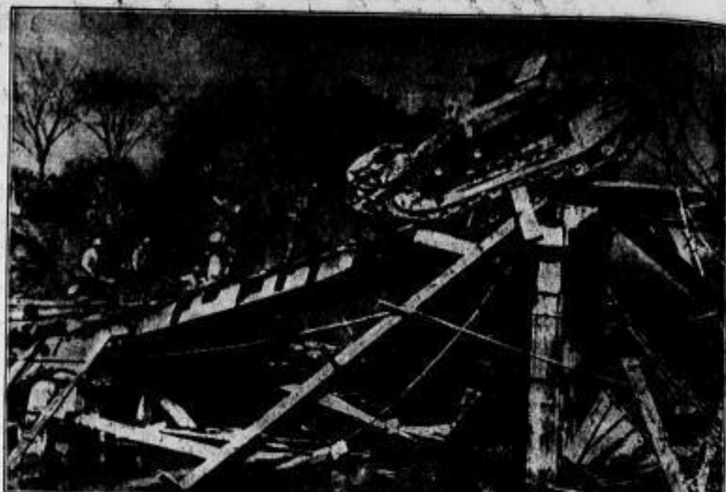
Bei dem Vormarsch der japanischen Truppen spielen die Tanks eine große Rolle, die mit größtem Wagemut alle Hindernisse überwinden, wie unser Bild zeigt. Die über Trümmern einer Brücke errichtete Balkenkonstruktion genügt dem Tank zur Weiterfahrt.
