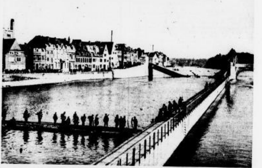
Unsere Pioniere errichteten die im Vordergrund sichtbare Notbrücke, über die nun der Vormarsch weitergeht. VR-Zeitungs-Verlag
