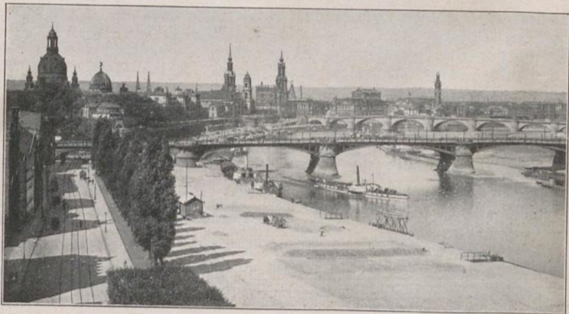
Blick auf die Carolabrücke
