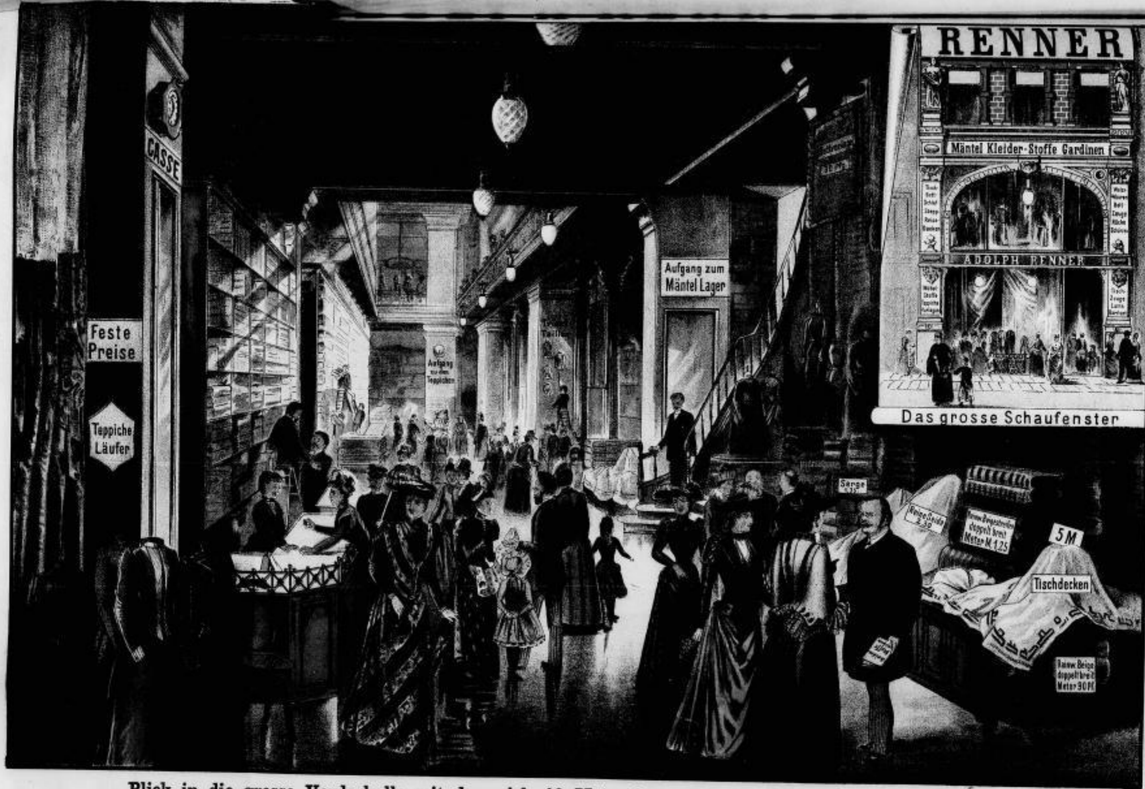
Blick in die grosse Vorderhalle mit dem sich 40 Meter lang erstreckenden Lager der Kleiderstoffe.
