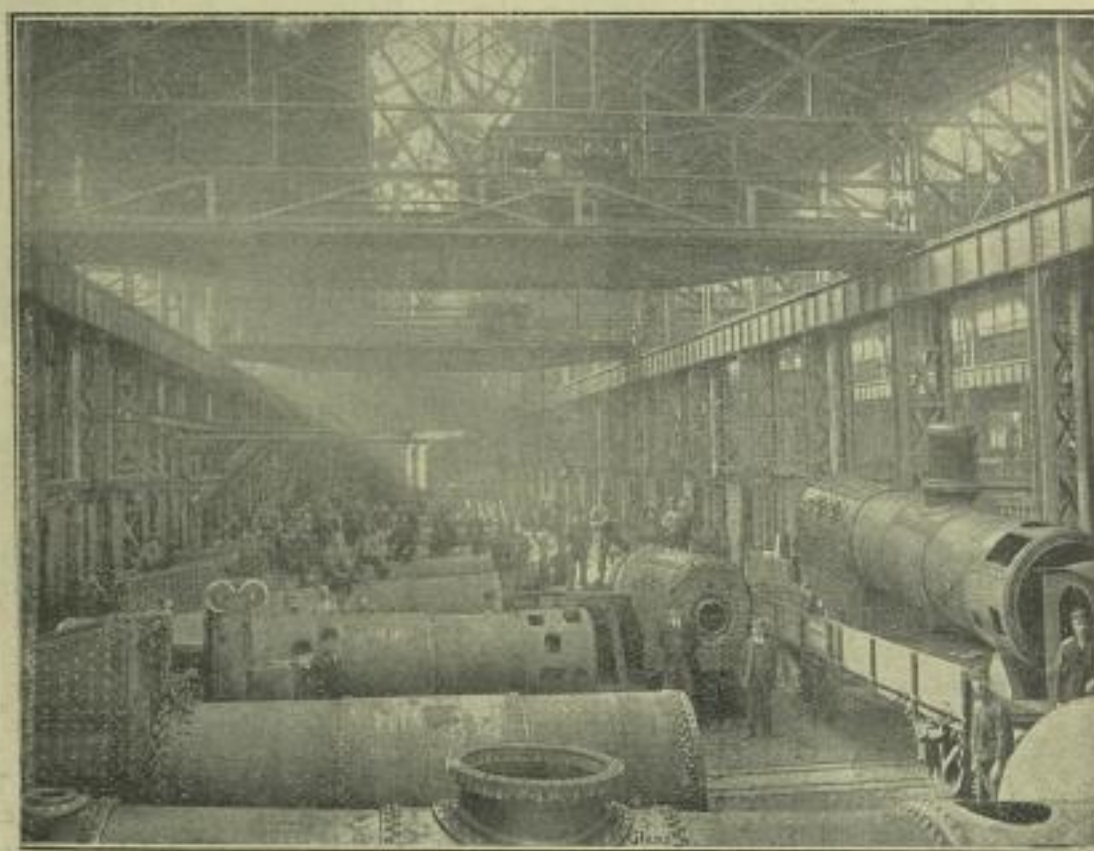
Fig. 6. Innere Ansicht der Kesselschmiede.
