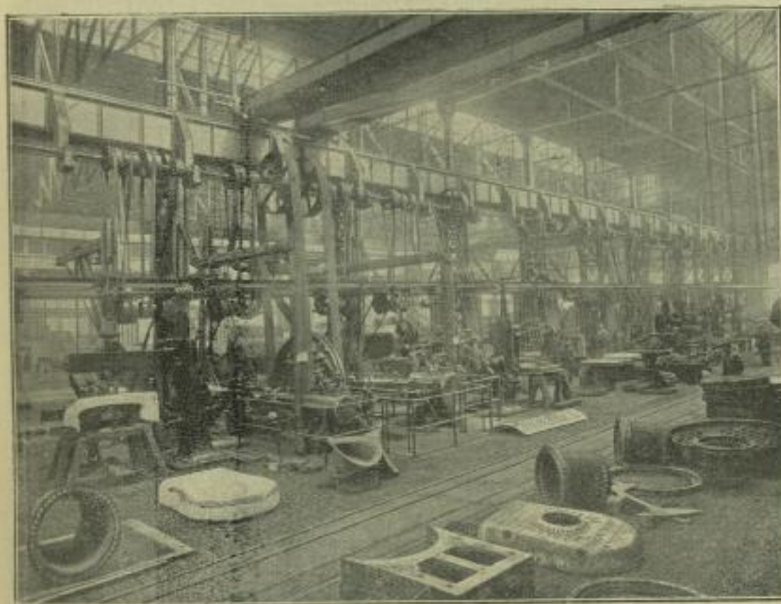
Fig. 5. Innere Ansicht der Kesselschmiede.
