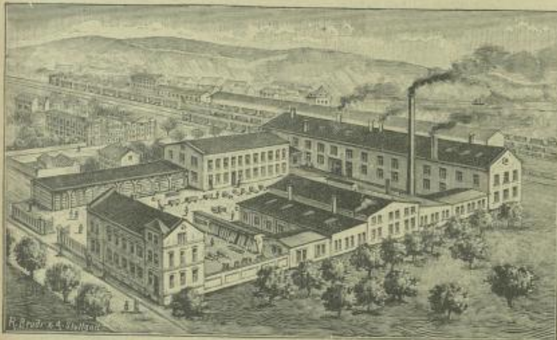
Fig. 1. Ansicht der Fabrik in Heidelberg.
