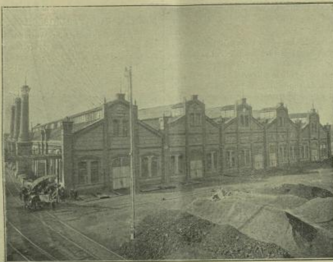
Fig. 4. Äußere Ansicht der Kesselschmiede.
