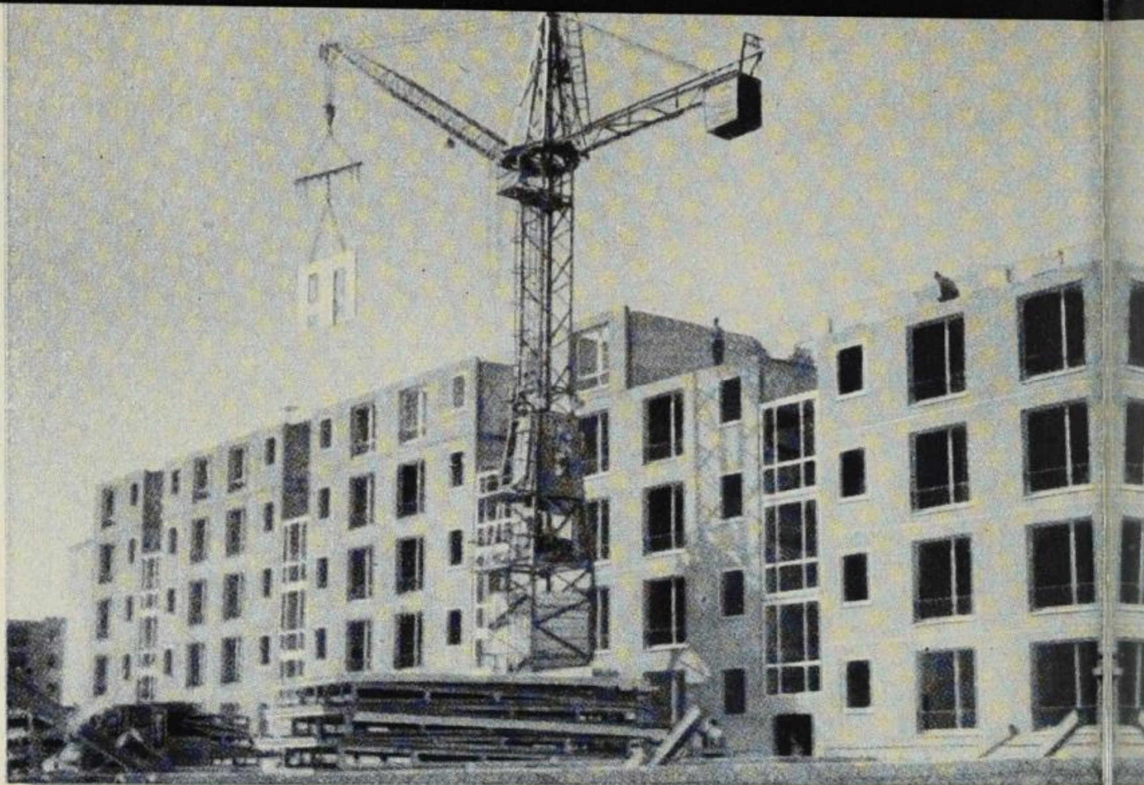
Construirea de locuințe din materiale prefabricate de beton
