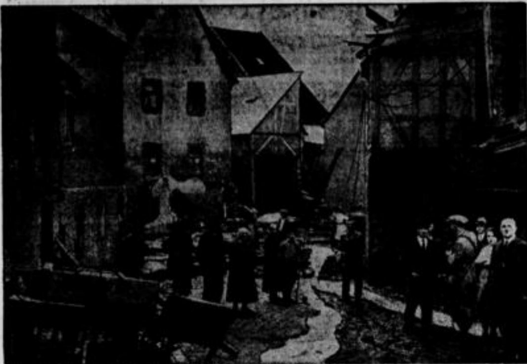
Schwerbeschädigte Häuser in dem hauptsächlich betroffenen Mosellort Sûls, wo allein 8 Tote aus den Trümmern geborgen wurden.
