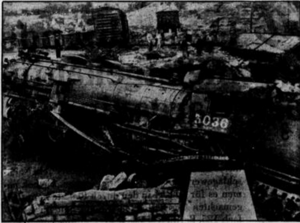
Die Lokomotive des Zuges, die in der Nähe von Bakersfield (Kalifornien USA) auf einem Damm entgleiste, der durch einen Wolkenbruch unterstellt worden war. Von dem Begleitpersonal des Zuges kamen viele in den Fluten um. Seltsamerweise vermochte sich aber gerade der Lokomotivführer zu retten.
