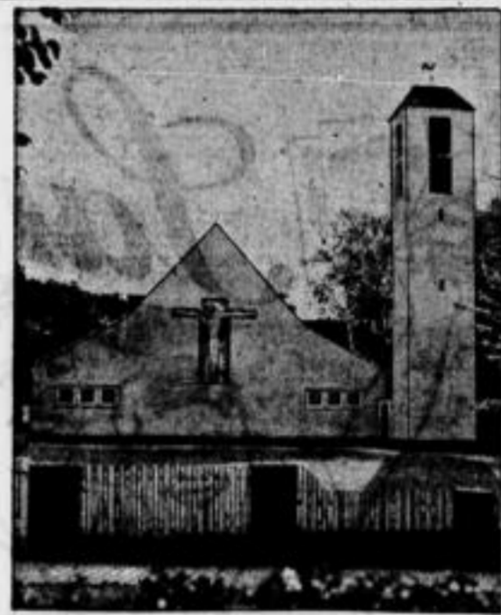
Vom Bildhauer-Meister zum Gotteshaus. Das neue evangelische Gotteshaus an der Berliner Heeresstraße.
