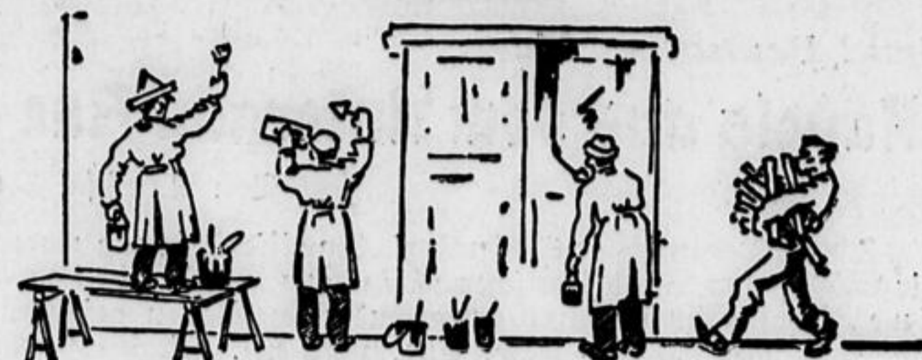
Auch Instandsetzungen werden gefördert.
