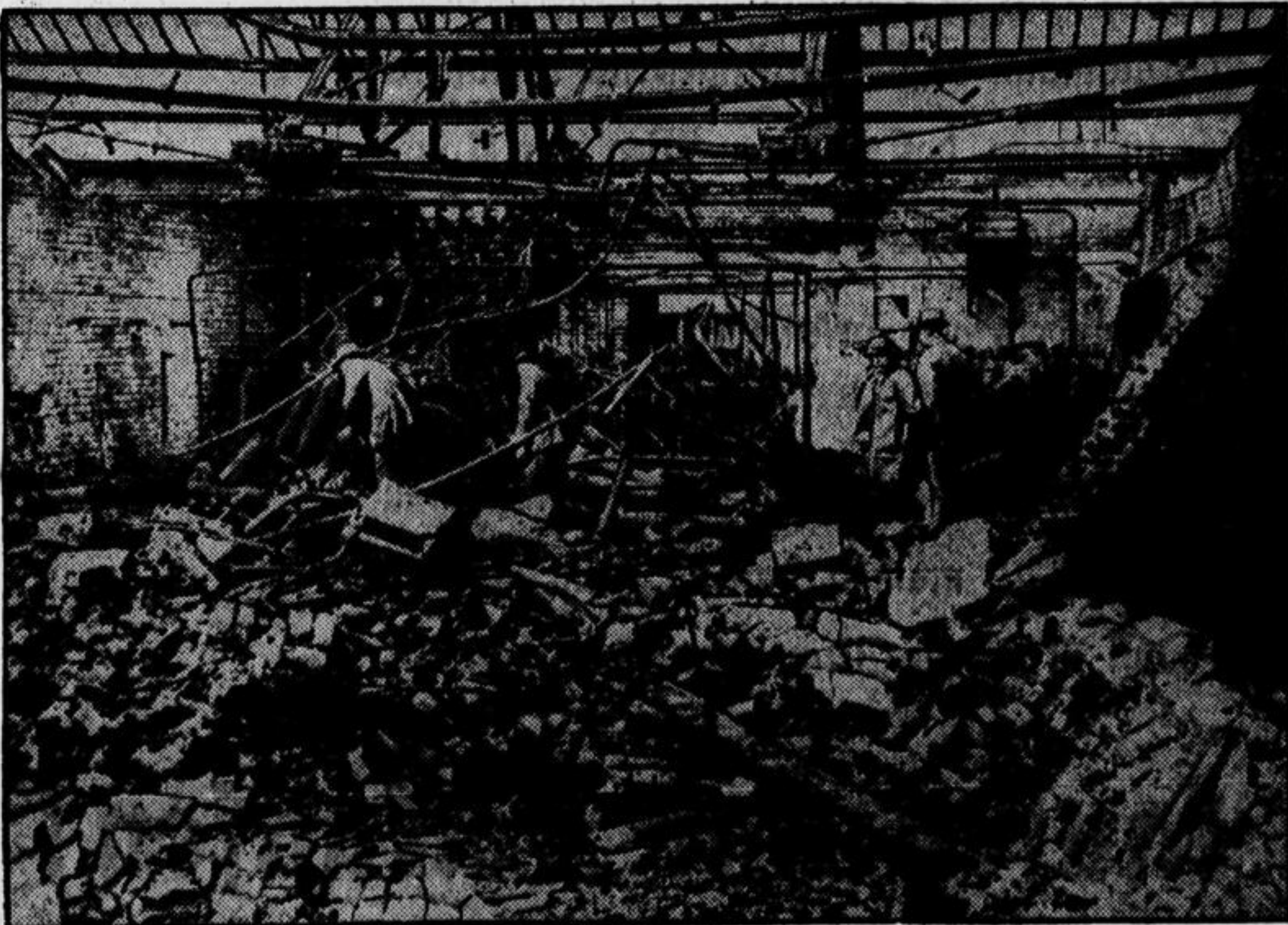
Die Trümmer der Sauerstoffabrik in Belgien, die durch eine schwere Explosion zerstört wurde. Hierbei fanden, wie der „G. V.“ bereits berichtete, drei Arbeiter den Tod.
