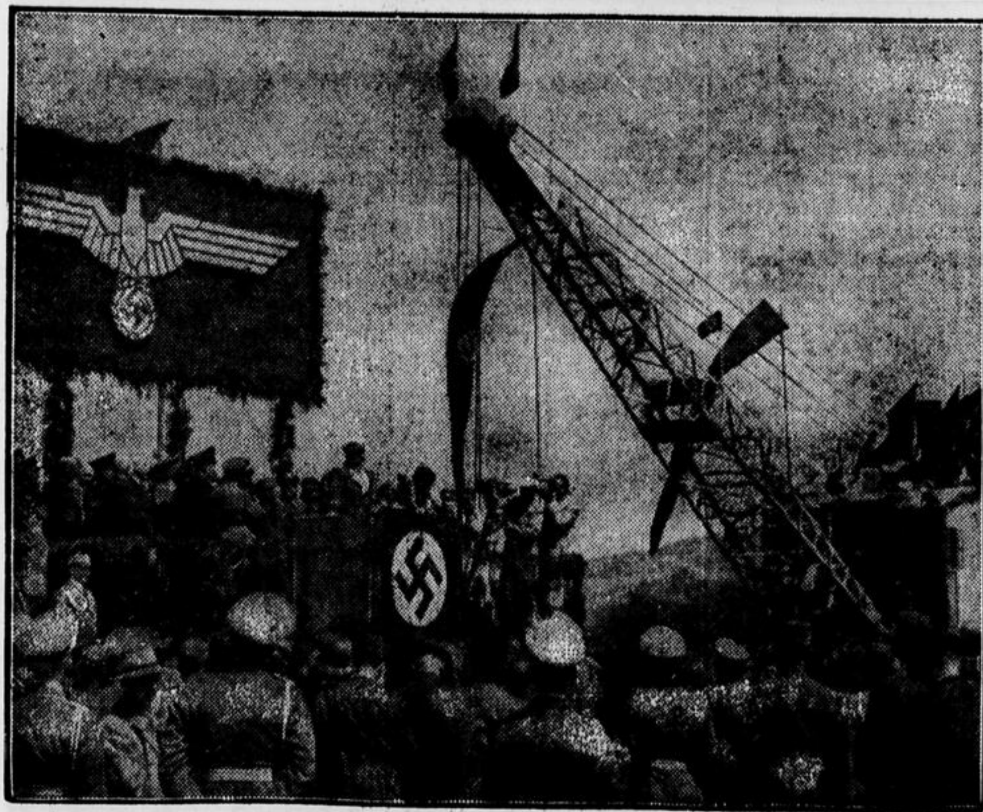
Der erste Spatenstich in Linz zur Errichtung der Reichswerke Hermann Göring. Unser Bild zeigt den Generalfeldmarschall am Rednerpult. Rechts der Riesenkrane, den die Kruppwerke in Essen lieferten. (Scherl-Bilderdienst-M.)
