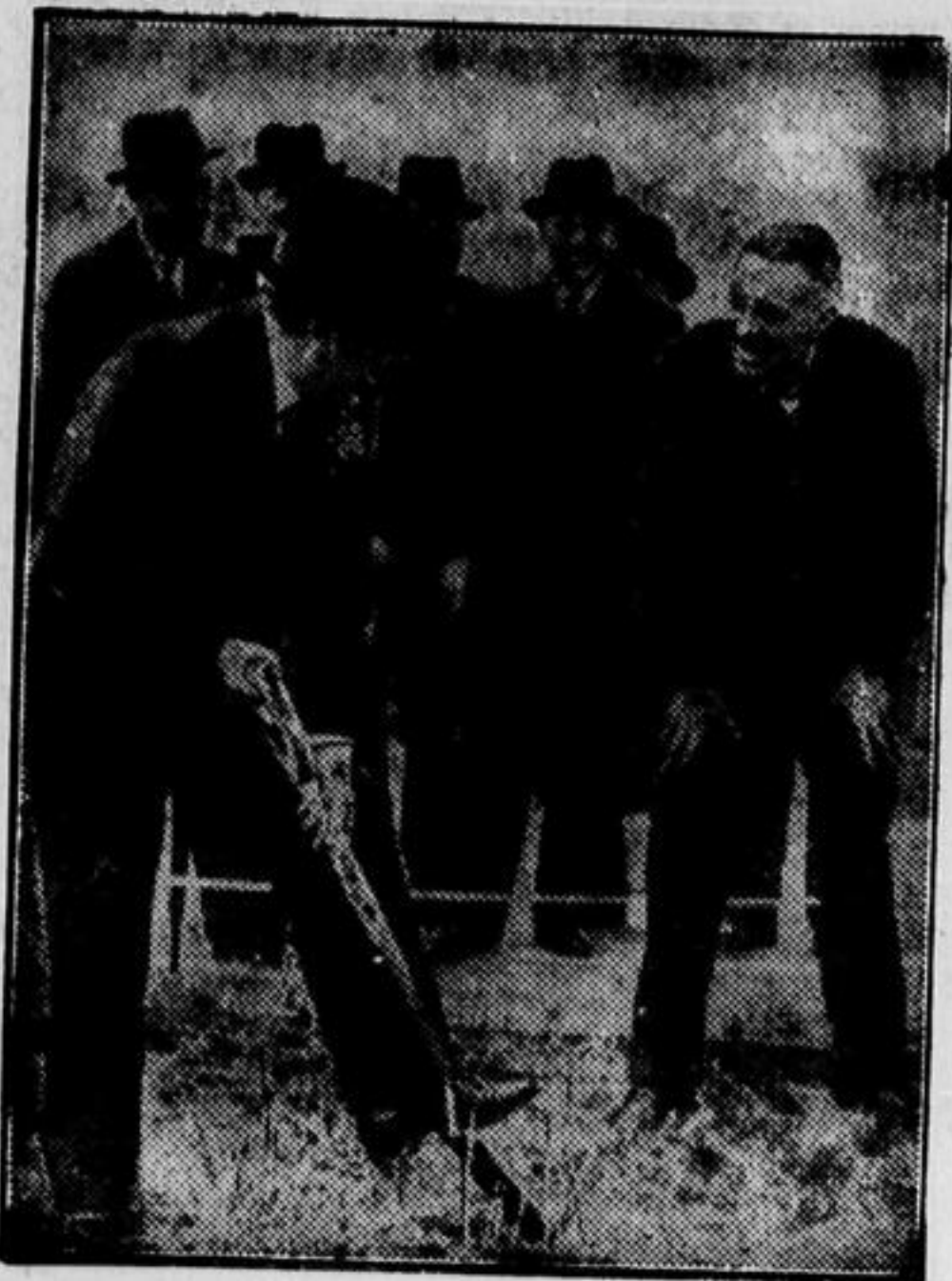
Spatenstich zu Englands größter Flugzeugfabrik. Luftfahrtminister Kingsley Wood vollzieht in der Nähe von Birmingham den ersten Spatenstich zum Bau der Flugzeugfabrik, bei der bereits 1000 Kampfflugzeuge bestellt worden sind. (Associated-Press-M.)
