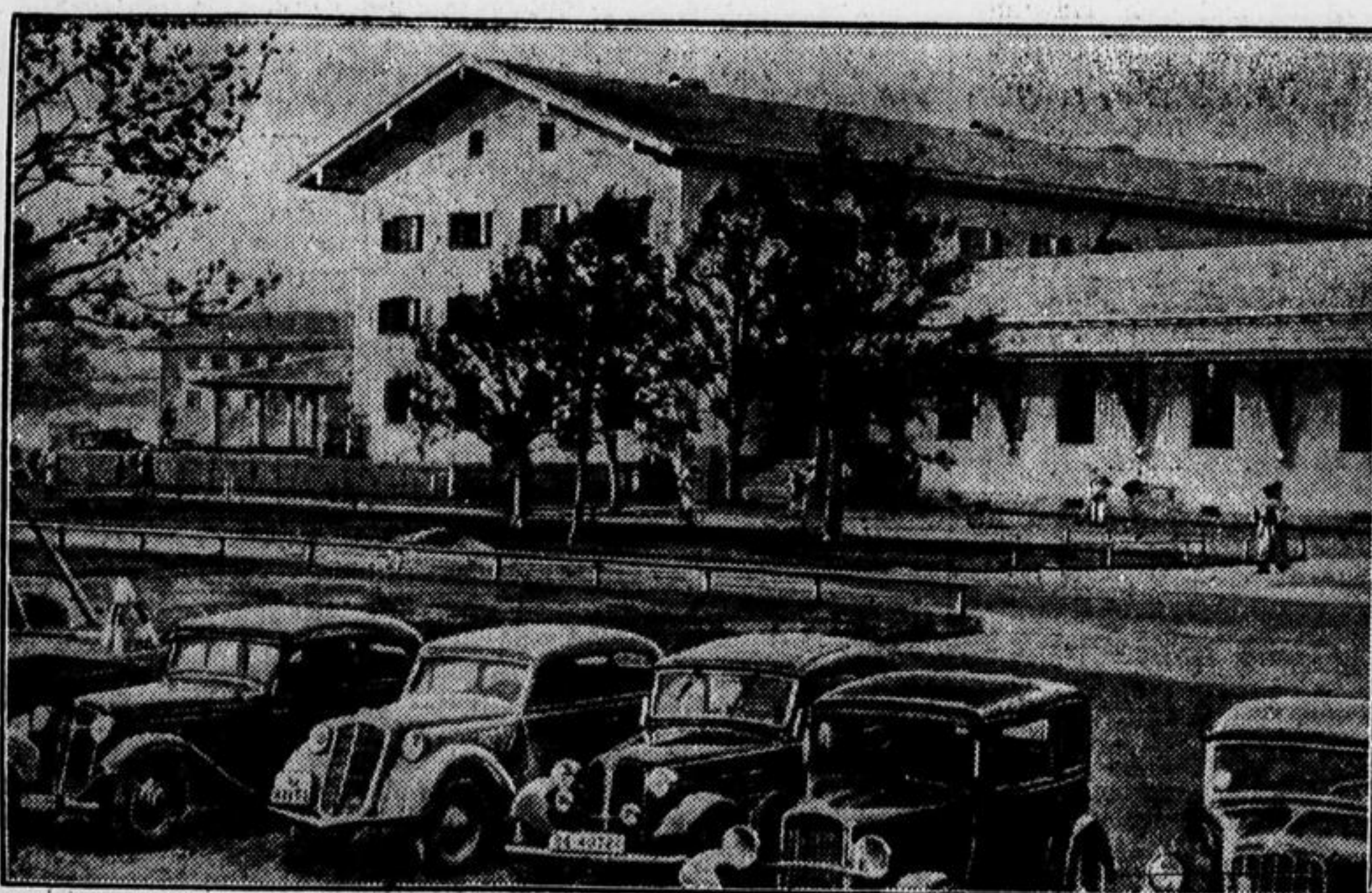
Das Krafthaus der Reichsautobahnen am Chiemsee, das sich in seiner Architektur der Landschaft aufs Beste anpaßt. Wie bereits mitgeteilt, wird es heute eröffnet. (Scherl-Bilderdienst-M.)
