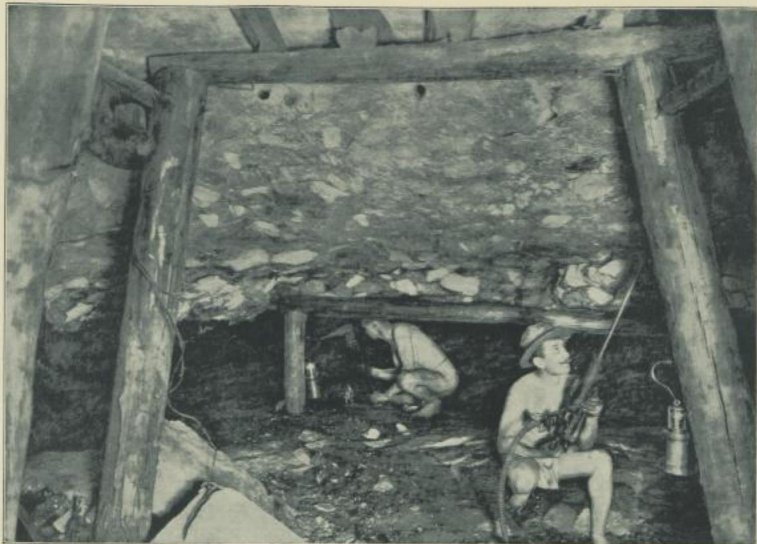
Abbau im Grundflöz mit Abwafchungs-Konglomerat
