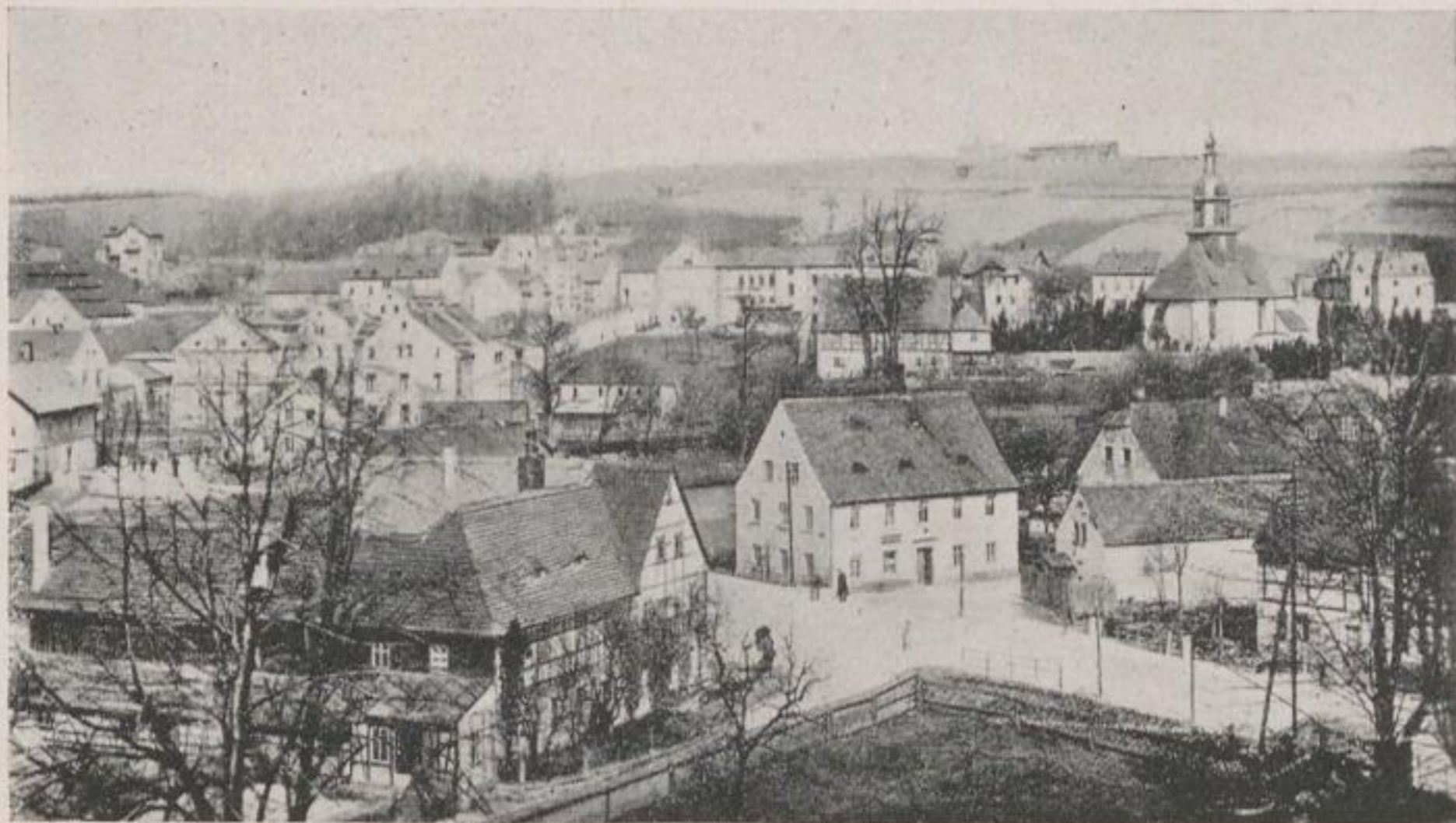
Straßenkreuz Dorfstraße — Durchgangsstraße an der heutigen Albertsburg
