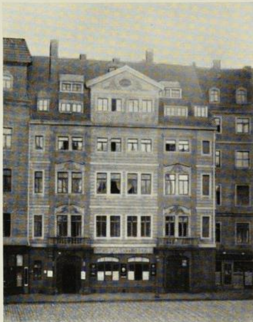
Regimentshaus am Neumarkt im heutigen Zustand
