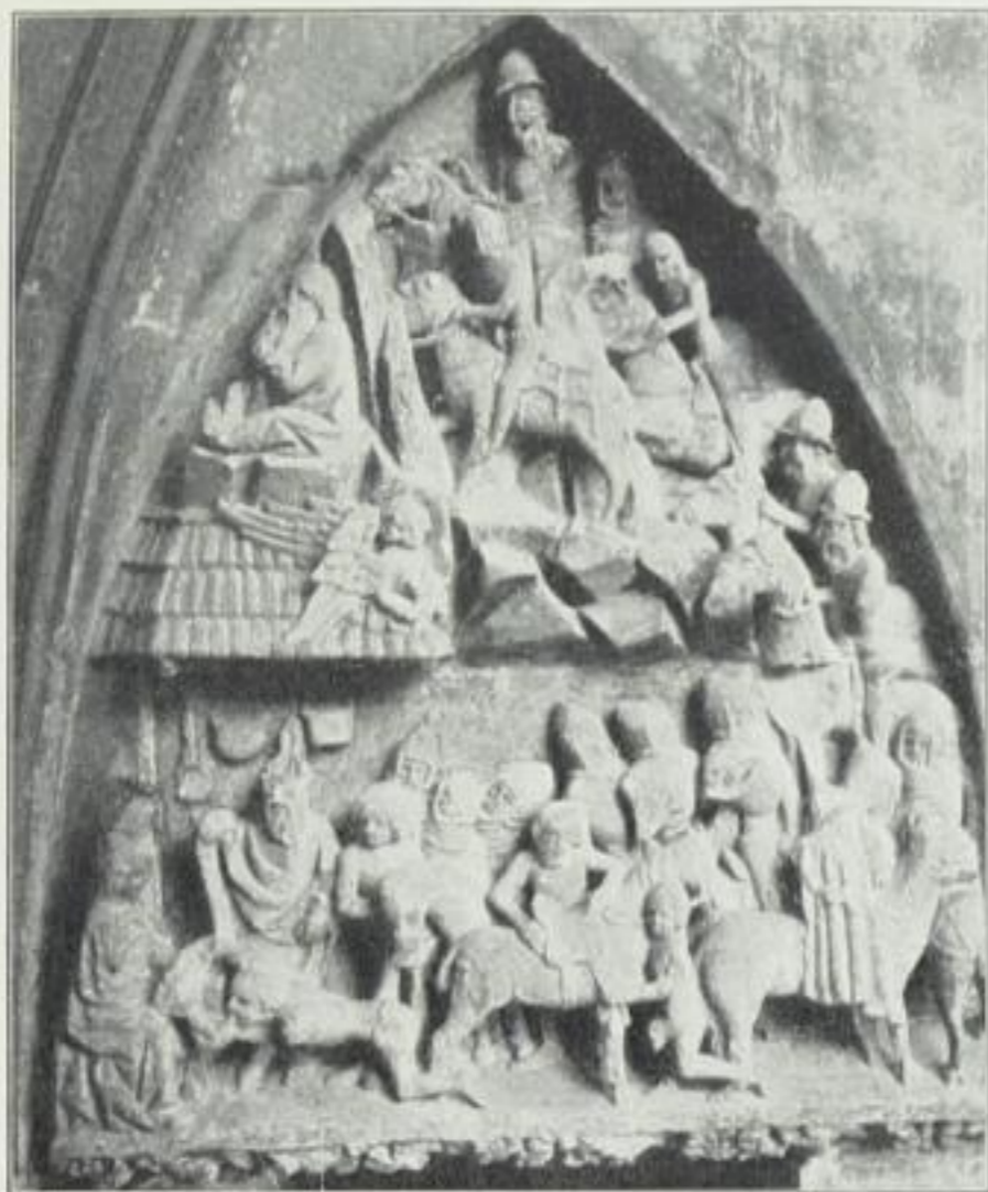
Abb. 39. Linker Teil des Südwestportals vor der Erneuerung
