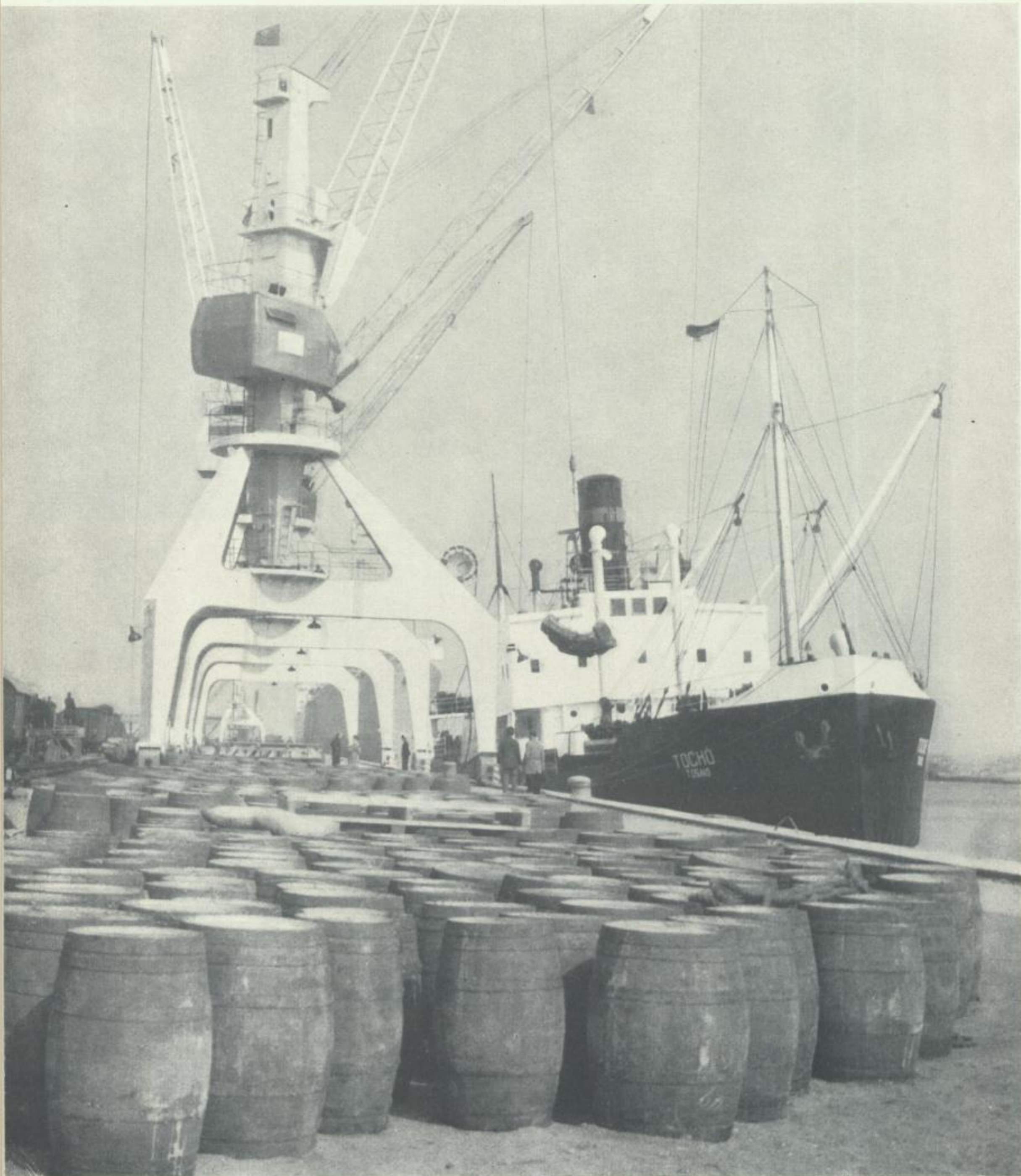
6 · Dreipunktgestützte Portalkrane im neuen Überseehafen Rostock Entwerfer: Horst Giese, Martin Kelm, Hochschule für bildende und angewandte Kunst, Berlin-Weißensee Hersteller: VEB Kranbau Eberswalde
