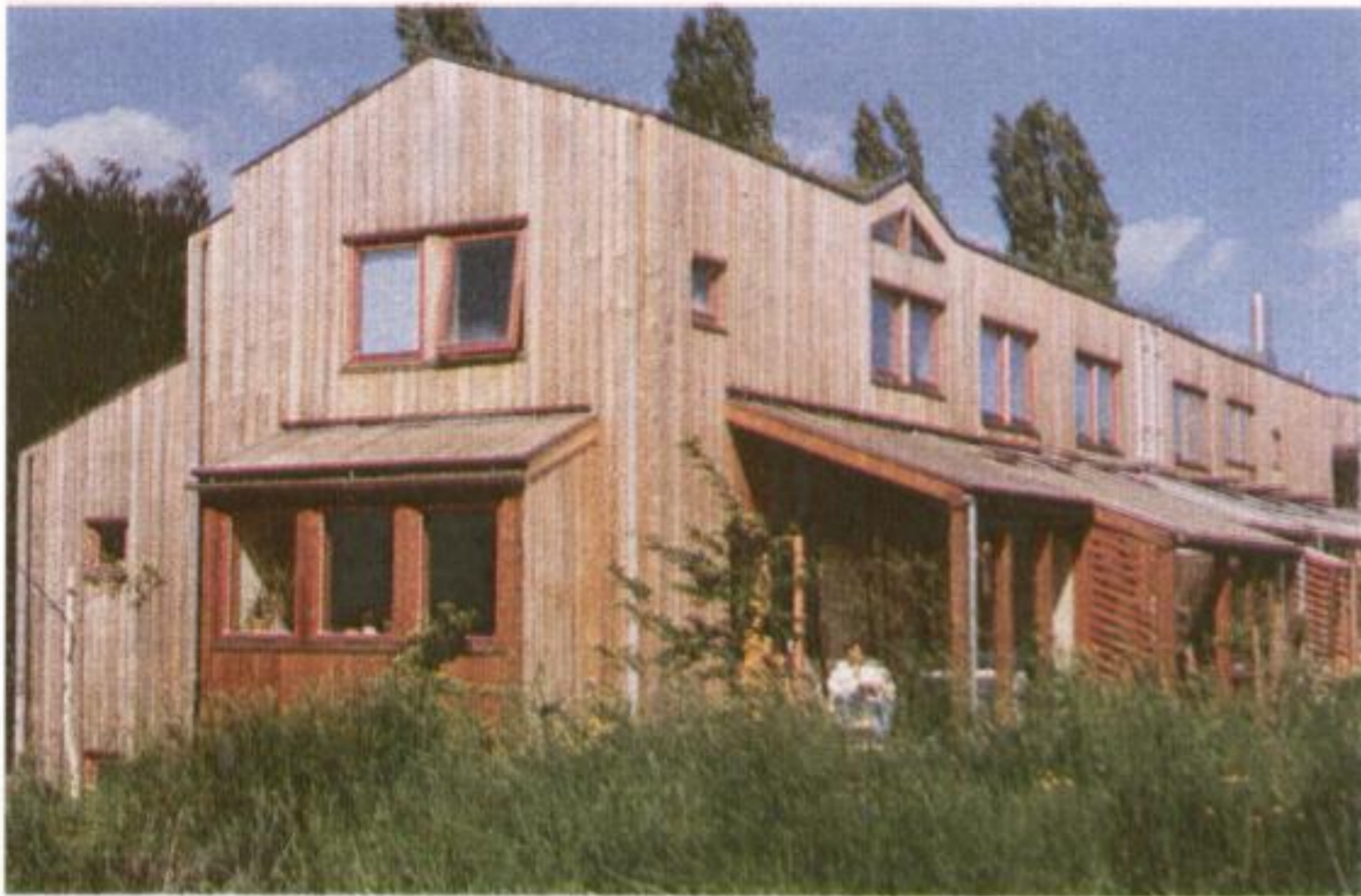
1/2 Ökologische Siedlung Kassel: Grasdächer speichern Regenwasser, verbessern das Mikroklima und sparen Heizenergie (sie wärmen im Winter und kühlen im Sommer) 3 Dachbegrünung eines Häuserblocks in Berlin- Kreuzberg 4 Efeu an einem Gebäude der Universität Marburg
