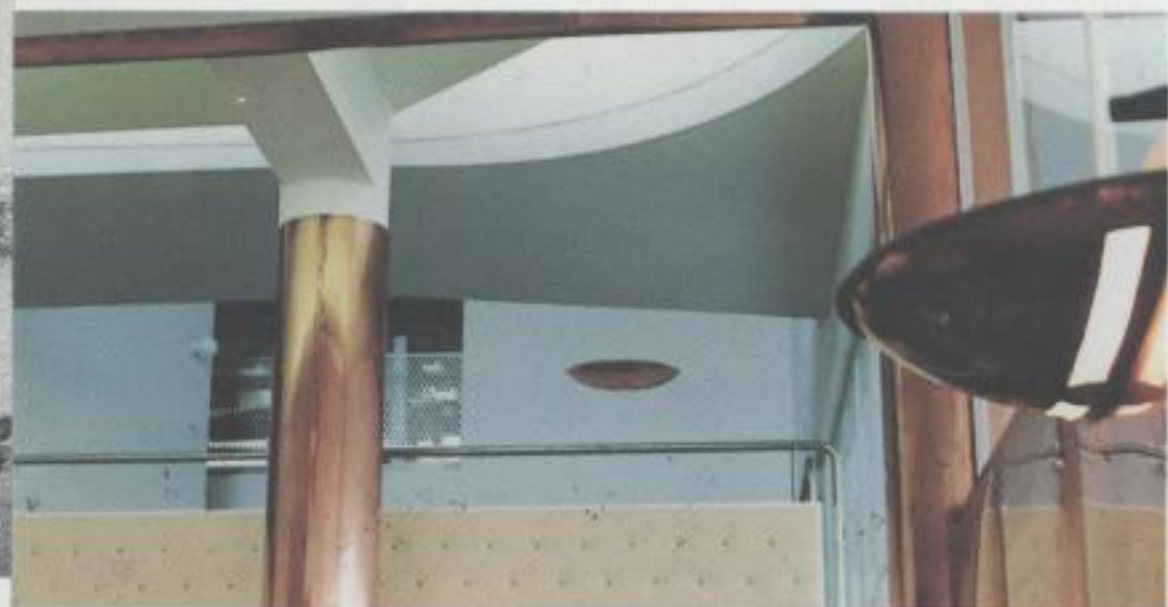
Grand Hotel "Gooiland", Nieuwsum, Architekten: J. Duiker, S. Bijvoet, 1934-1936. Eingehängte Brücke, Ansicht vom Erdgeschoss aus
