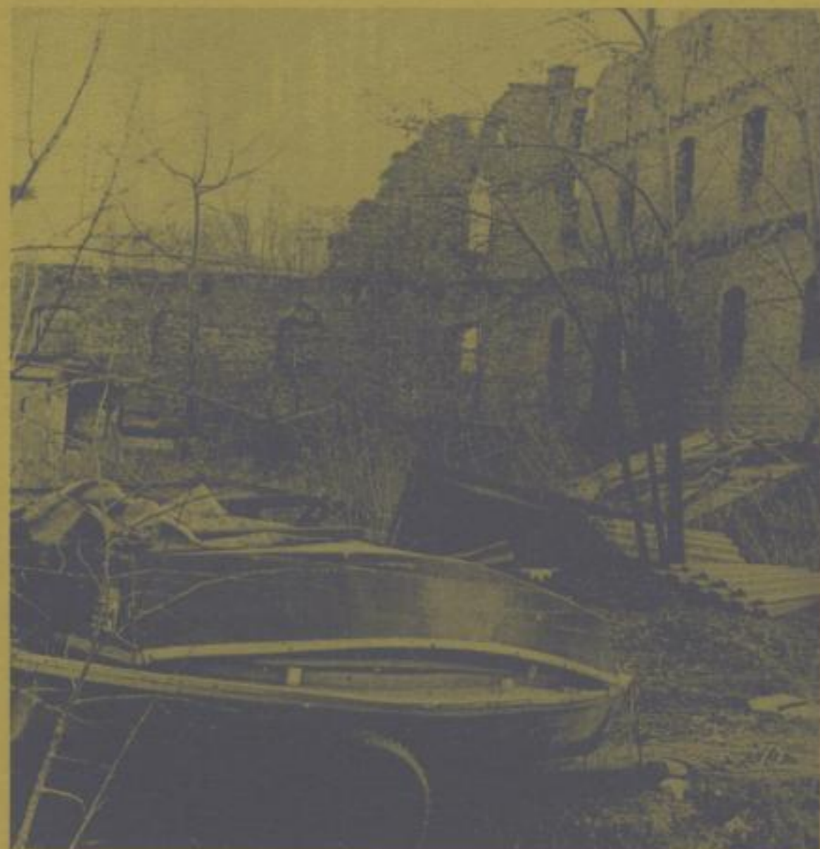
Wallwitzhafen, jetziger Zustand der Ruine
