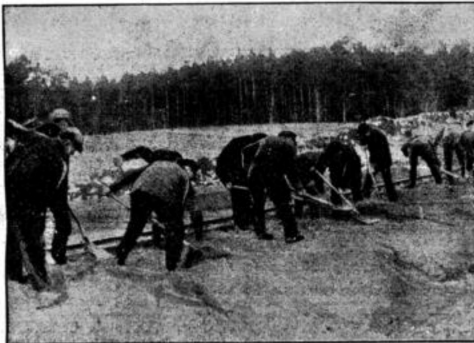
Der Bau der Reichsautofraße Berlin-Stettin
