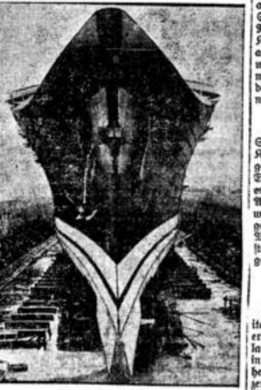
Vor dem Stapellauf des größten Dampfers der Welt Der französische 75 000-Tonnen-Dampfer „Normandie“, der mit einer Länge von 311 Metern und einer Breite von 36 Metern nach seiner Fertigstellung das größte Passagierschiff der Welt darstellen wird, ist jetzt soweit fertig gebaut worden, daß der Stapellauf in den nächsten Tagen stattfinden wird. Der Riesendampfer ist für den Passagierdienst auf der Strecke Le Havre—Newport bestimmt.
