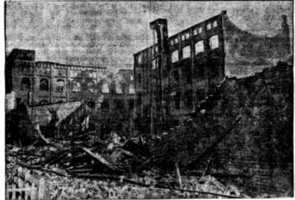
Tiefgründer Fabrikbrand in Berlin-Neudörfen Die ausgebrannten Ruinen des Fabrikgebäudes und des Holzspeichers
