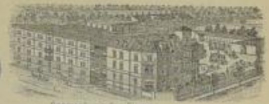
Centralküchen der Firma
