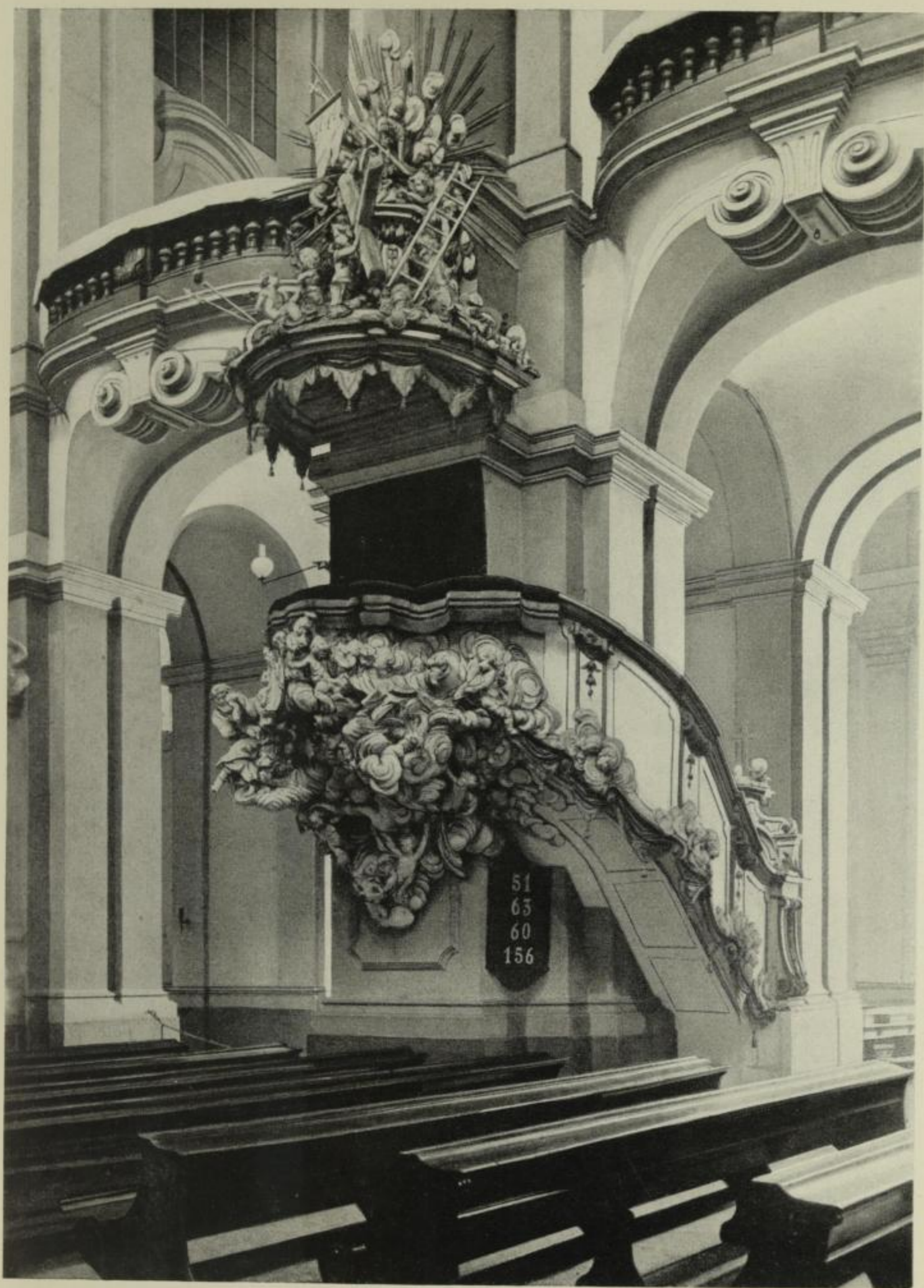
62 Katholische Hofkirche. Kanzel vor der Zerstörung
