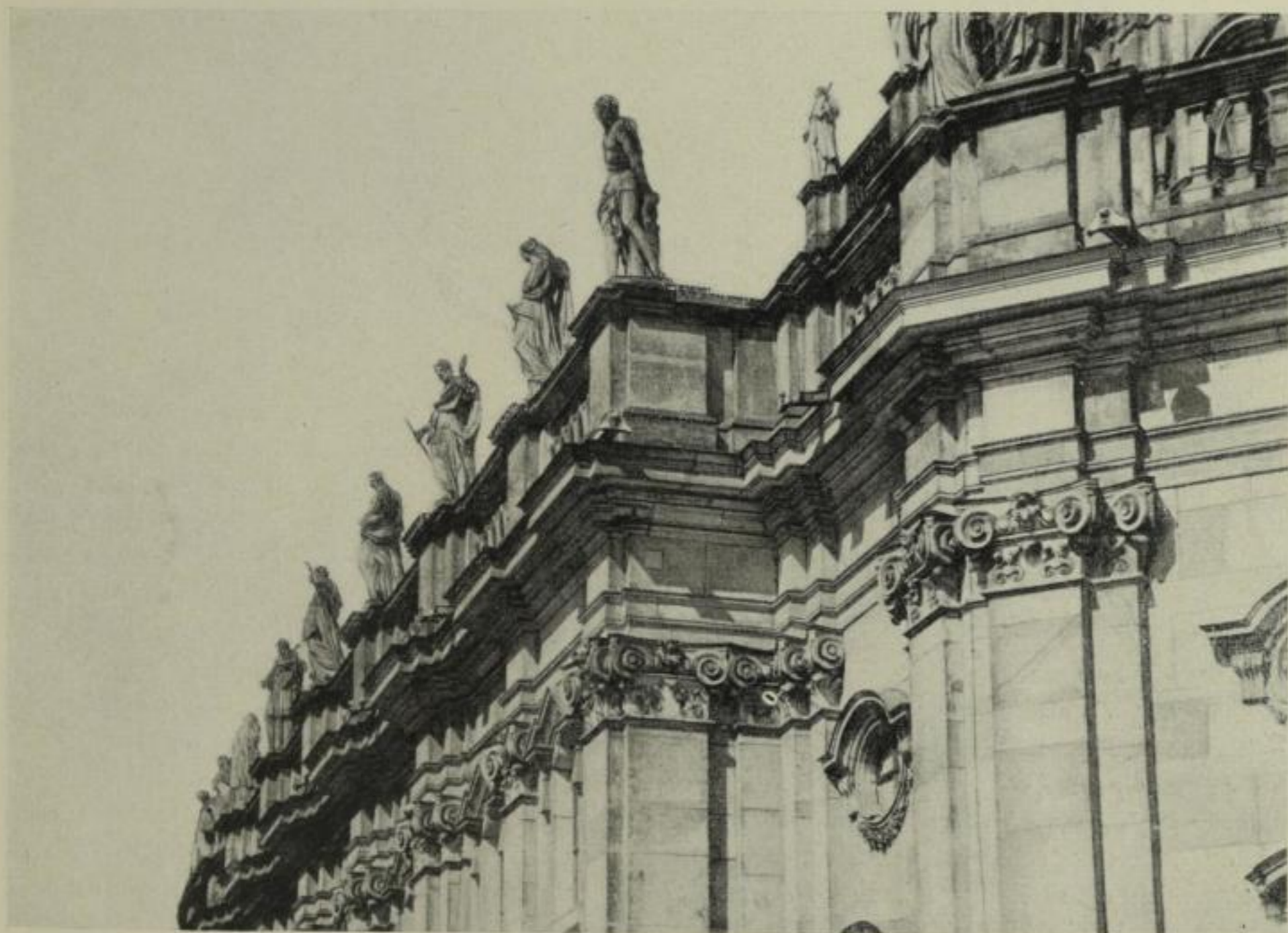
46 Katholische Hofkirche. Südostseite
